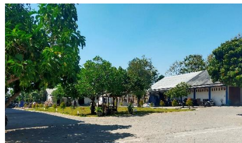
Gambar 1. Lokasi Pembangunan Gudang Bahan Baku di PT. Samudra Sunan Drajad Lamongan (sumber: PT. SSD Lamongan)
