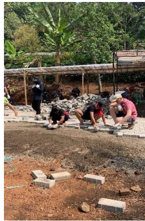
Gambar 2.2 Pemasangan Paving
