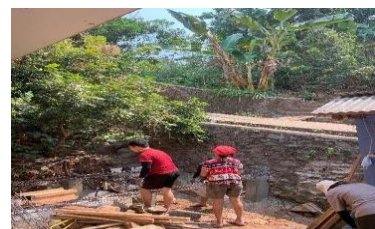
Gambar 6.2 Membangun Toilet Umum
