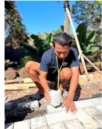
Gambar 2.3 Penguncian Paving
